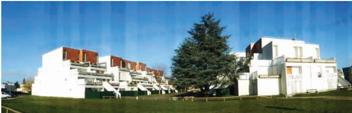
Habitat collectif, modèle type « gradin jardin » (architectes Andrault et Parat 1975) Rue des Riottes
