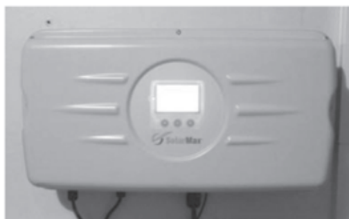
Figure 9. – Onduleur relié aux panneaux photovoltaïques
