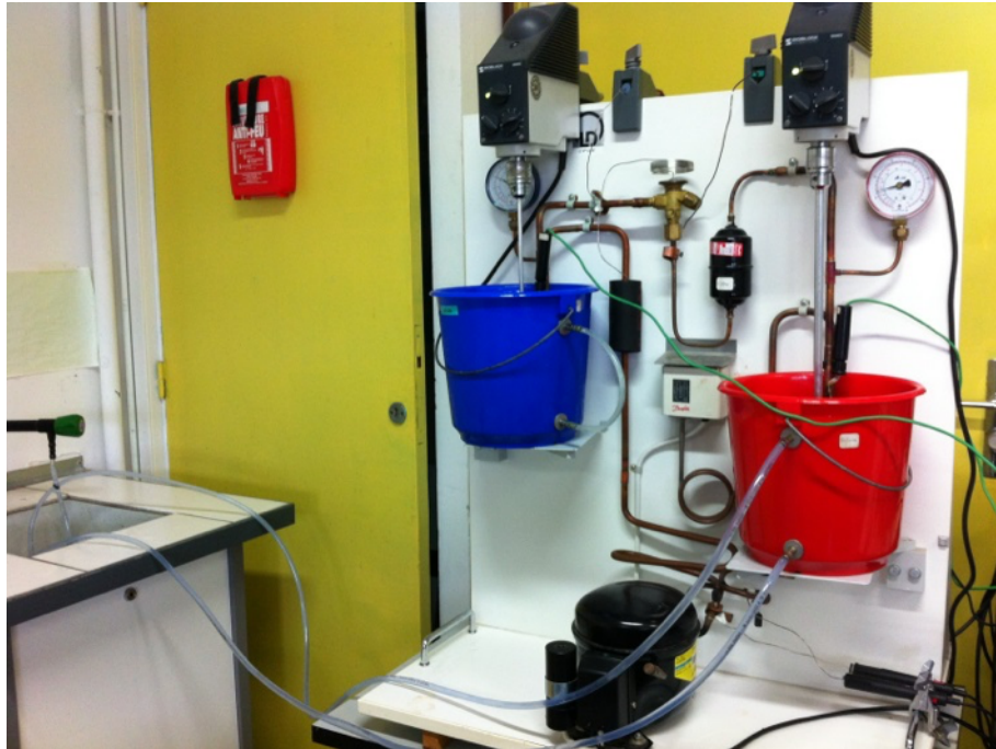
Figure 8 Pompe à chaleur avec dispositif de refroidissement
