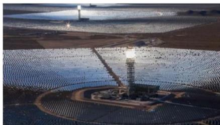
Mise en service en 2013, la centrale thermique solaire d'Ivanpah est équipée de 173 000 miroirs qui dirigent la lumière du Soleil vers un absorbeur. L'énergie est ensuite utilisée par un générateur de vapeur, cette dernière permet de faire tourner un alternateur qui génère de l'électricité.
