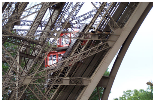
Figure 1 Chariot tracteur supportant les deux cabines de l'ascenseur du pilier nord de la tour Eiffel
